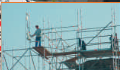
31 mètres en haut de l'échafaudage.
