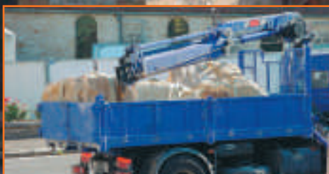
40 m 3 de pierres sont nécessaires.
